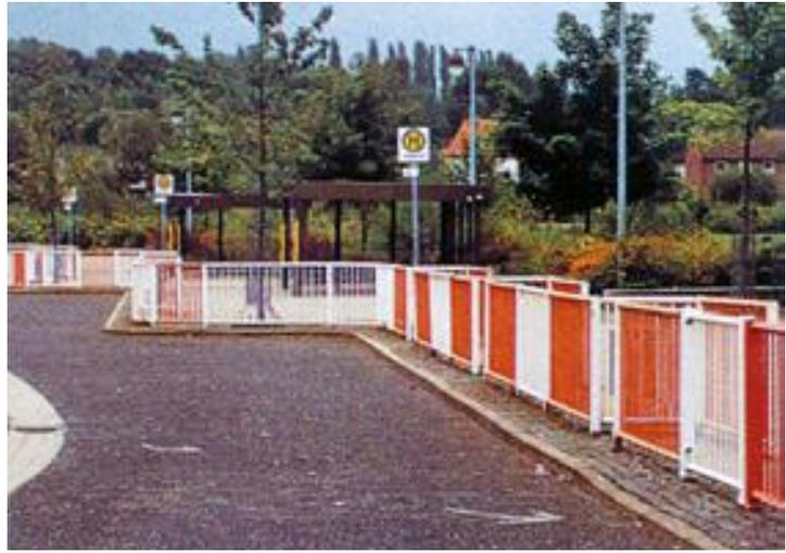
Die Befestigung der Zaunfelder an den senkrechten Pfosten ist so konstruiert, dass die unterschiedlichsten Grad- bzw. Winkelstellungen ausgeführt werden können. Bei den Querholmen der Zaunfelder zeigt immer eine Kante der Vierkanthrohre nach oben, um Turnkünste zu verhindern.
